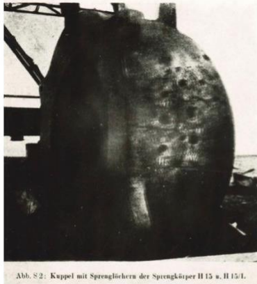
Abb. S 2: Kuppel mit Sprengkernen der Sprengkörper H 15 u. H 15/L.
